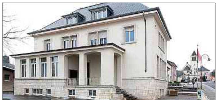
Das Gemeindehaus im derzeitigen Zustand.
