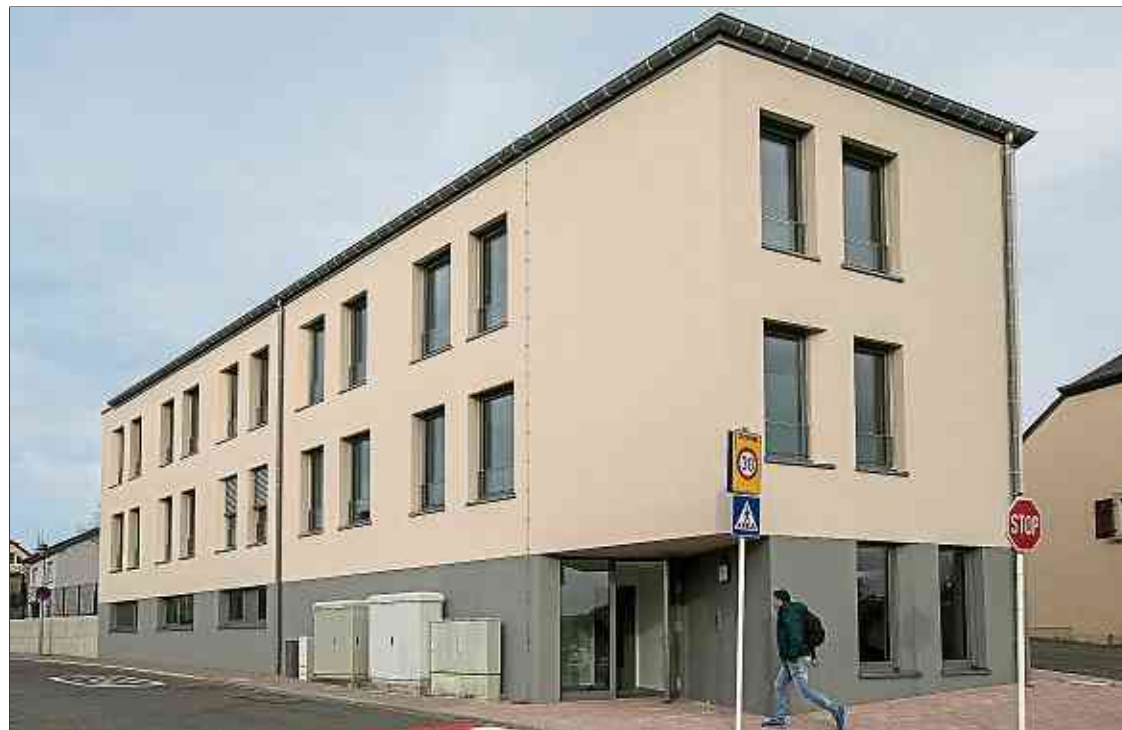
Anstelle der Schule thront nun in Bergem ein Wohnheim für berufstätige Junggesellen. Neben den 18 Studios verfügt das Gebäude auch über einen Gemeinschaftsraum mit Küche. (FOTOS: GUY JALLAY)
