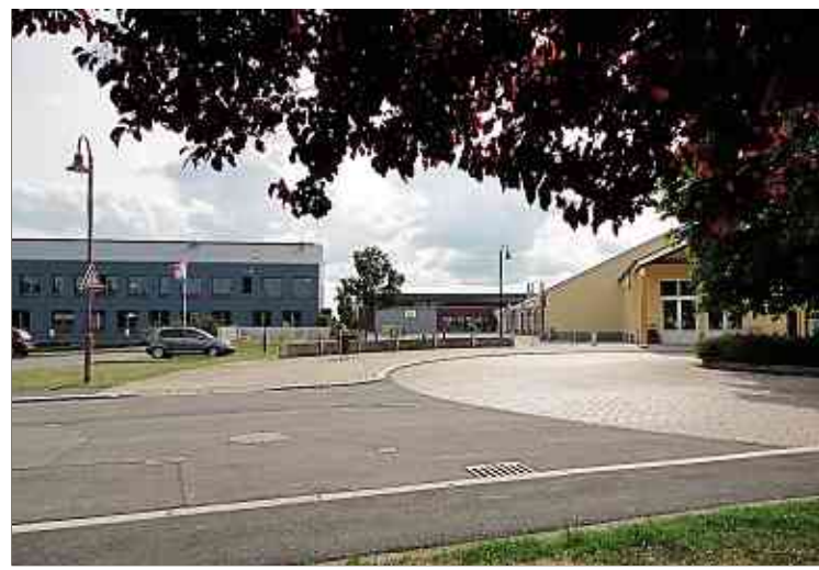
Auf dem Stellplatz am Reckinger Kleesenberg wird zusätzlicher Raum für die Maison relais geschaffen. (FOTO: RAYMOND BONARIA)
